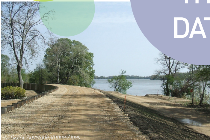
© DREAL Auvergne-Rhône-Alpes Travaux de sécurisation des digues - Arles
