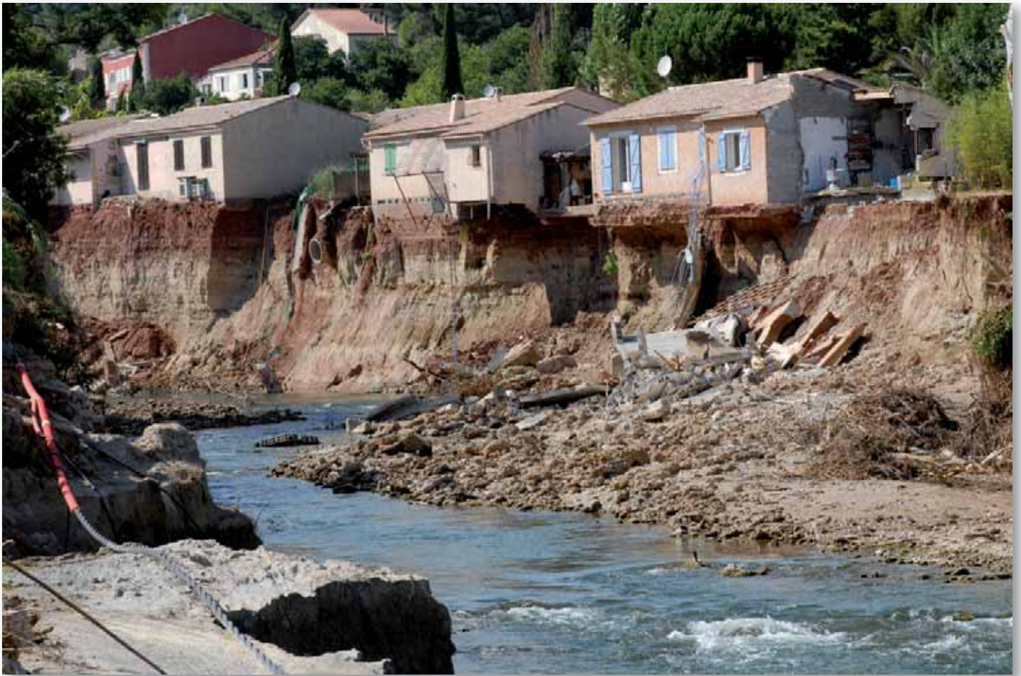
Inondations du Var- Destruction de plusieurs habitations sur la commune de La Motte suite à la crue de la Nartuby - Juin 2010 © IRMa - S. Gominet
