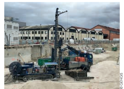
Forage de sondes géothermiques verticales en fond de fouille sous un futur bâtiment de bureau.
