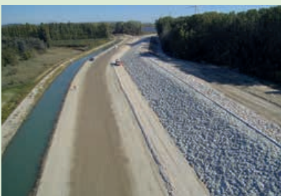
Digue résistante à la surverse de Beaucaire à Fourques.
