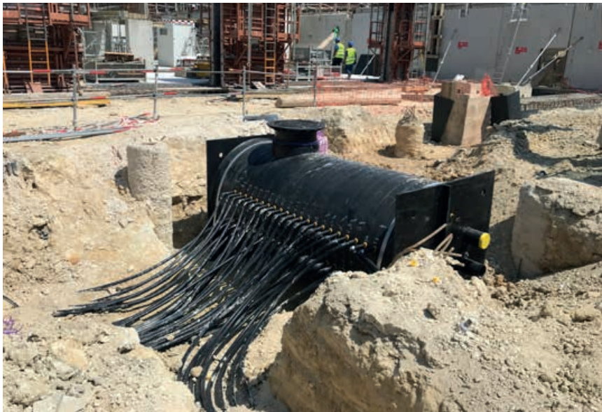
Collecteur de sondes géothermiques verticales enterré.
