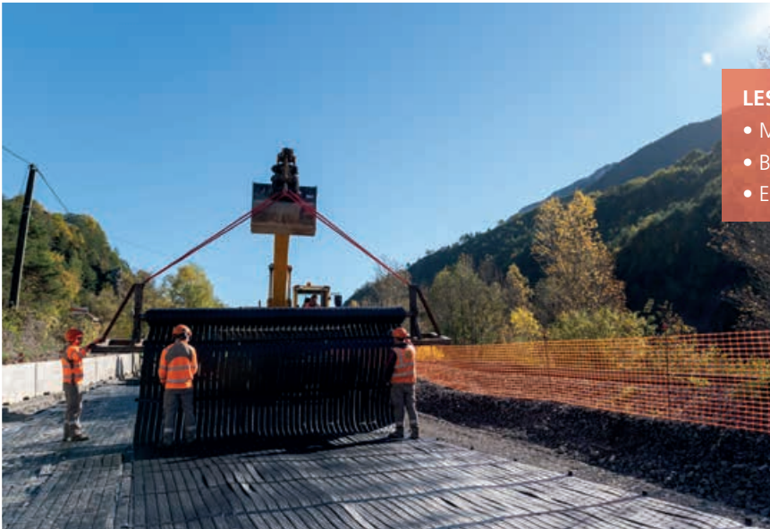
Mise en œuvre de la ParaLink 1500.
