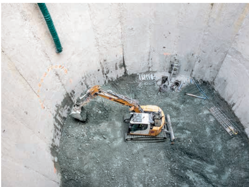
Chantier de l'ouvrage de service OA1 aux pieds des pistes de l'aéroport d'Orly.
