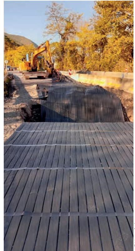
Vue de la tranchée d'ancrage depuis la zone protégée. En arrière-plan, la longueur de recouvrement à rabattre sur la tranchée après remblaiement et compactage.
