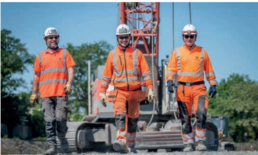
L'équipe du chantier.
