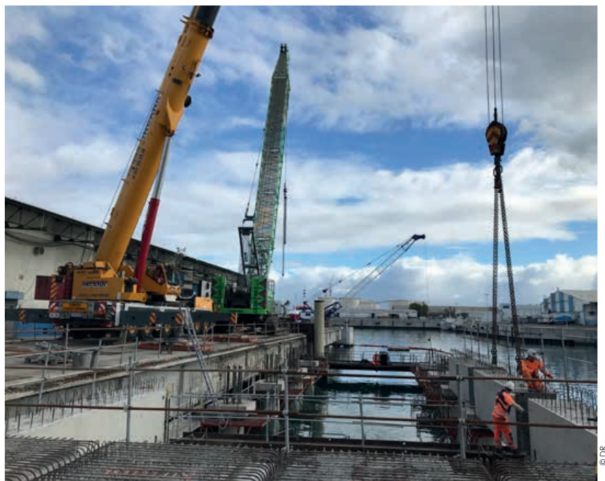
Mise en place des poutres longitudinales.
