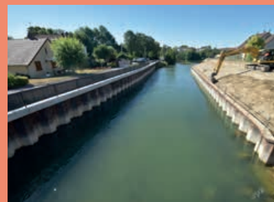
Réhabilitation des digues du Fouchy à Troyes.
