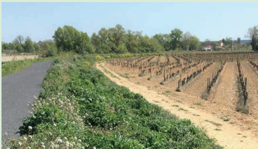
Vue de la digue après végétalisation du géomatelas.
