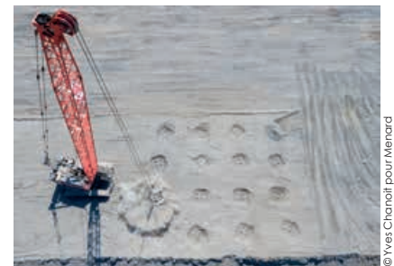
Densification du sol par compactage dynamique.
