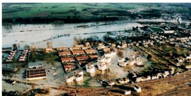
Crue au port de Givet.
