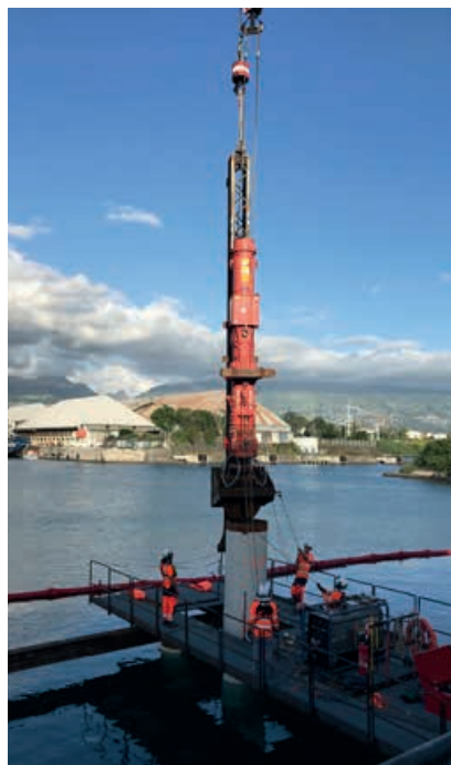
Phase de battage des pieux.
