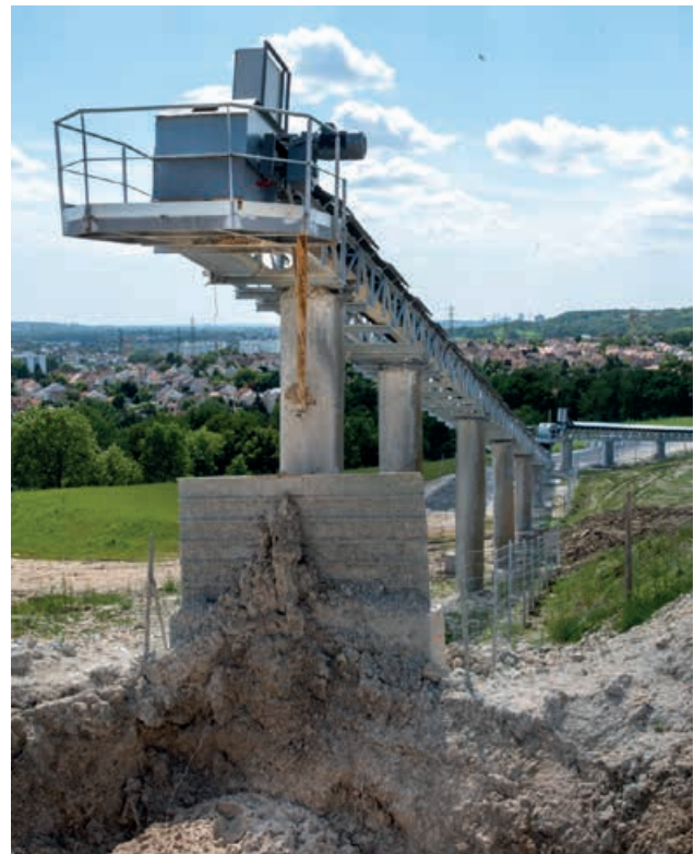
Évacuation par bande transporteuse de déblais du puits de tunnelier Bel-Air à Chelles jusqu'au projet d'aménagement de la plaine du Sempin.
