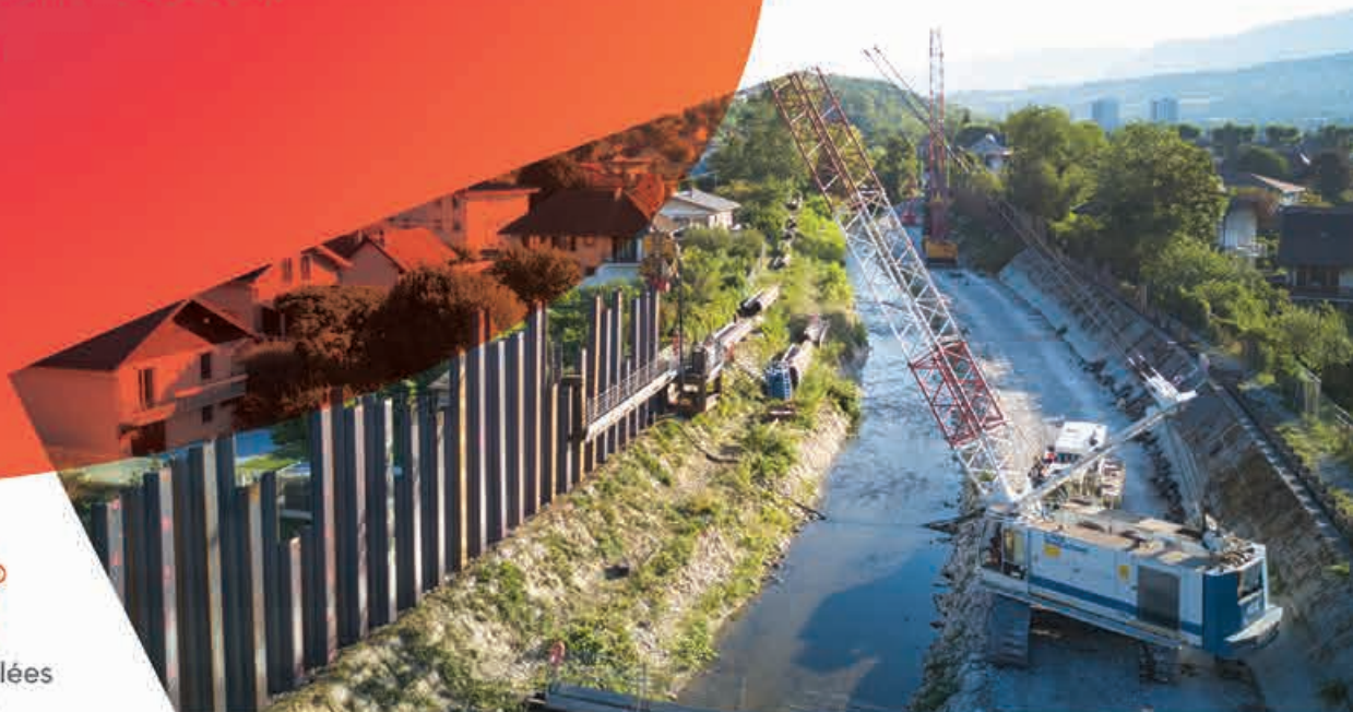
Digue du Serrioz, Aix-les-Bains | France, 2019 ©NGE Fondations
