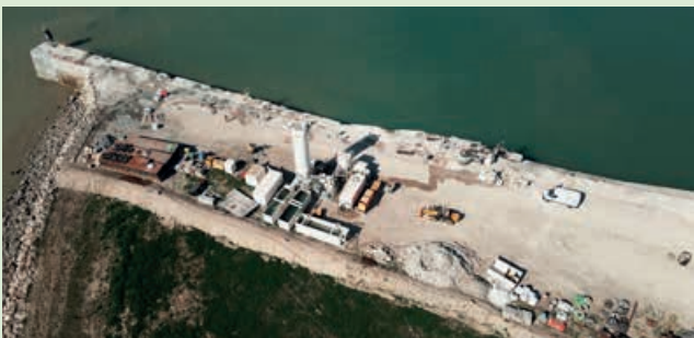
Vue aérienne du chantier.
