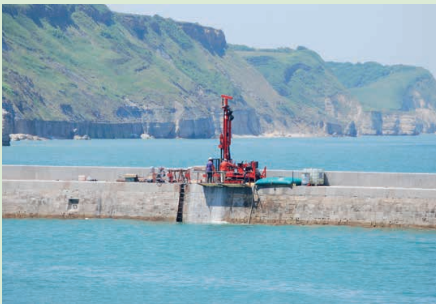
Forage sur le môle ouest.
