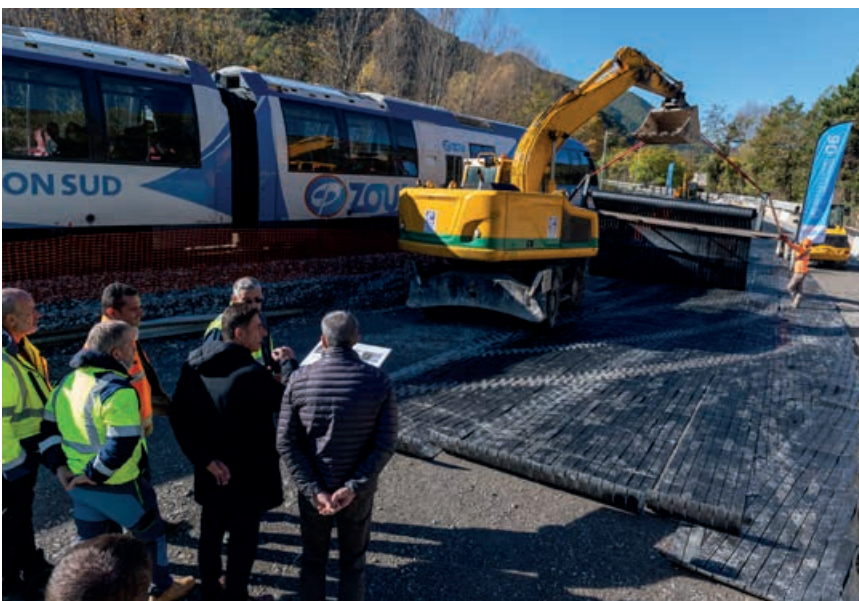
Chantier très contraint avec d'une part le train des pignes et d'autres part le travail en demi chaussée.
