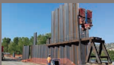
Confortement de digue à Saint-Laurent-du-Var.
