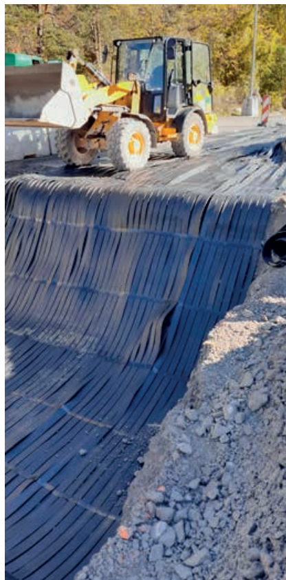
Tranchée d'ancrage. Un engin à pneu peut circuler directement sur la ParaLink.
