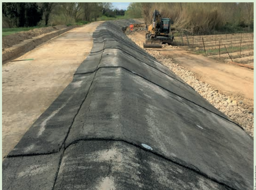
Vue du géomatelas fixé avec amarres Fenox.
