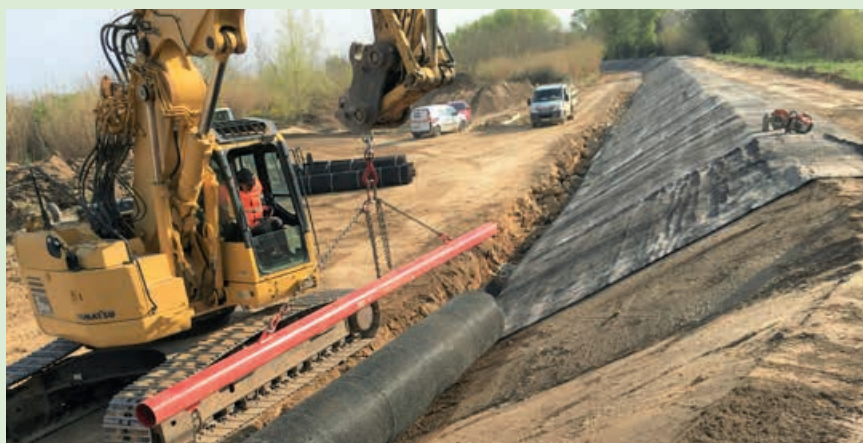
Déroulement du géomatelas EnkaMat A20 sur la digue.
