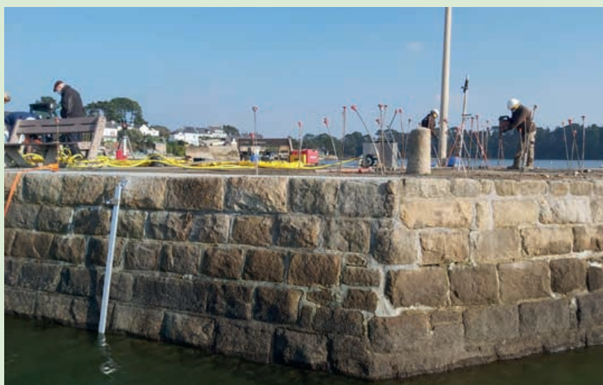
Mise en place des tubes à injections.
