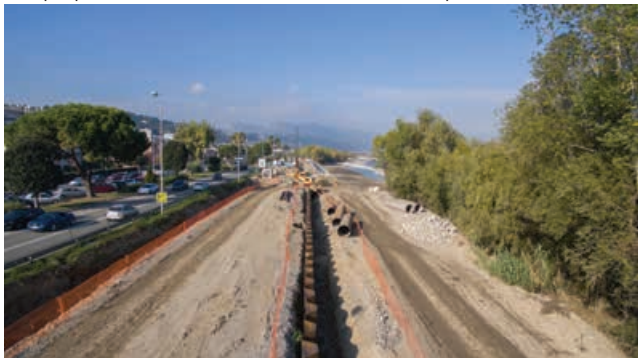
Digue à Saint-Laurent-du-Var.
