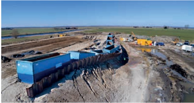
Test de rupture.
