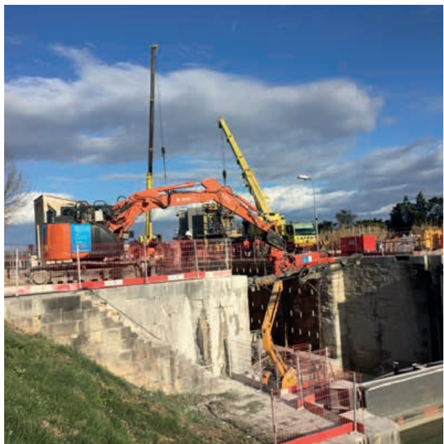
La pelle travaille ici du haut de l'écluse, en rétro, le bras de la pelle tendu, avec la glissière horizontale qui fore sous les chenilles de la pelle.
