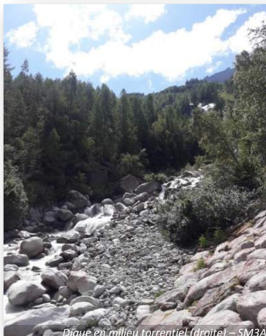
Digue en milieu torrentiel (droite) – SM3A
